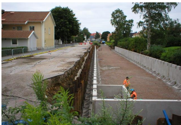
Bild 8: Dagvattenanläggning under mark vid Lärkgatan
