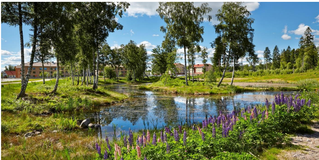
Bild 1: Dagvattenanläggning vid Östra Lugnet med syfte att rena dagvattnet innan det når recipienten.
