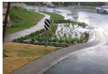
Exempel på s.k. "raingarden" som tar hand om dagvatten som uppstår på gatan vid kraftiga skyfall.
